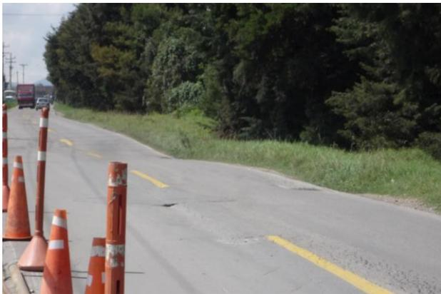
Figura 1: Patologías generadas por cambios volumétricos del suelo
