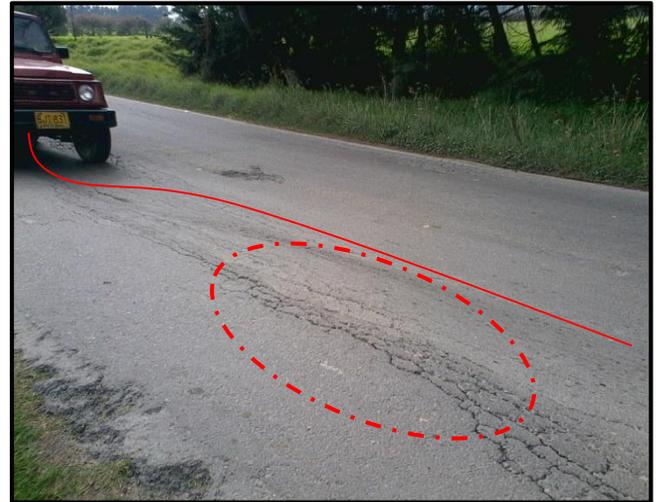
Figura 6. Consecuencias de la desecación de arcillas, en vías pavimentadas al occidente de Bogotá D.C. Fuente: propia.
