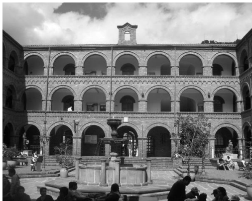
Figura 1: Fachada interna del edificio Alberto E. Ariza
