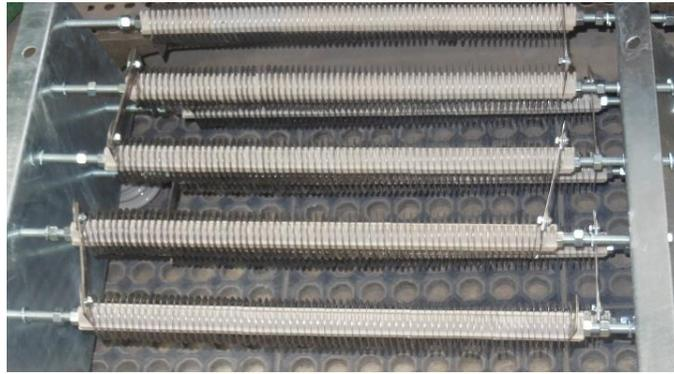
**Figura 1: Juego de resistencias eléctrica para control dinámico de frenado**
