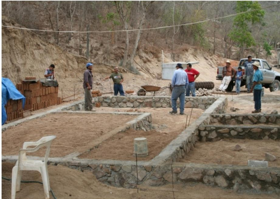
**Figura 6: Cimentación con una profundidad de 1 metro**
