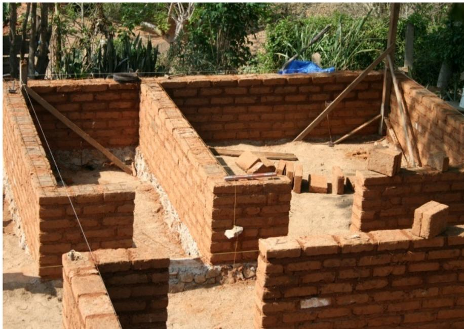
**Figura 7: Construcción de muros**
